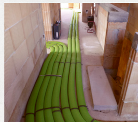
Компактное размещение плоских воздуховодов Air Excellent в конструкции пола
