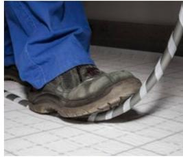
Быстрая фиксация труб без использования инструментов. Простой монтаж силами одного человека
